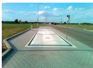
Waga samochodowa betonowa wersja zagłębiona
